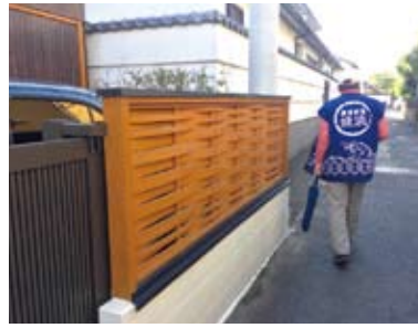
旧宮の前…お寺の裏路地の塀の改修
